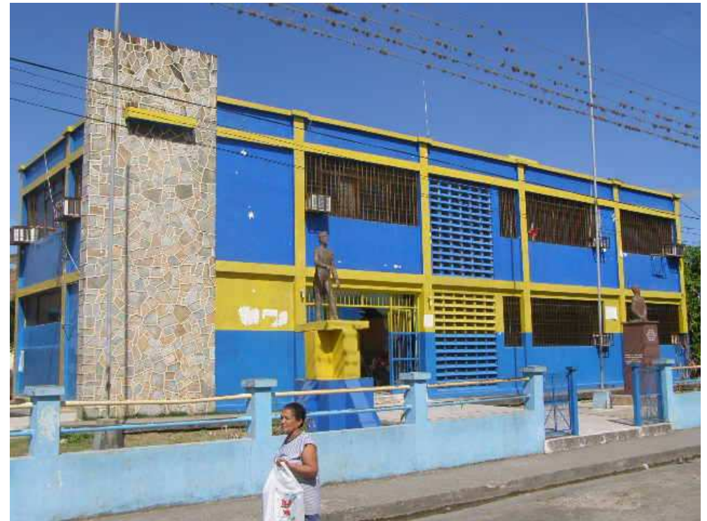
Palacio Municipal construido en el año 1962
