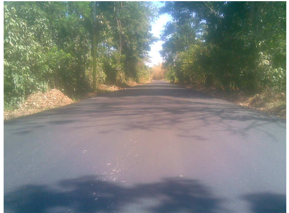
Asfaltado de la carretera que une Yaguaraparo al Golfo.
